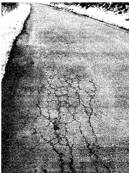
Obr.3 – km 0,800 a Obr.4 – km 1,200 : konstrukční poruchy při okraji vozovky
