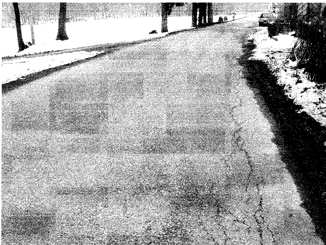
Obr.5 – km 1,400 ; trhliny a deformace vozovky
